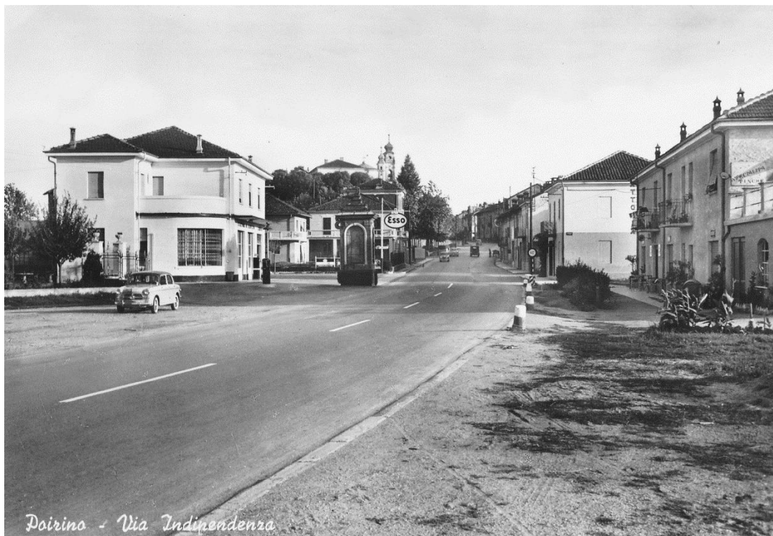
Entrata a ponente dopo la rimozione dei binari
