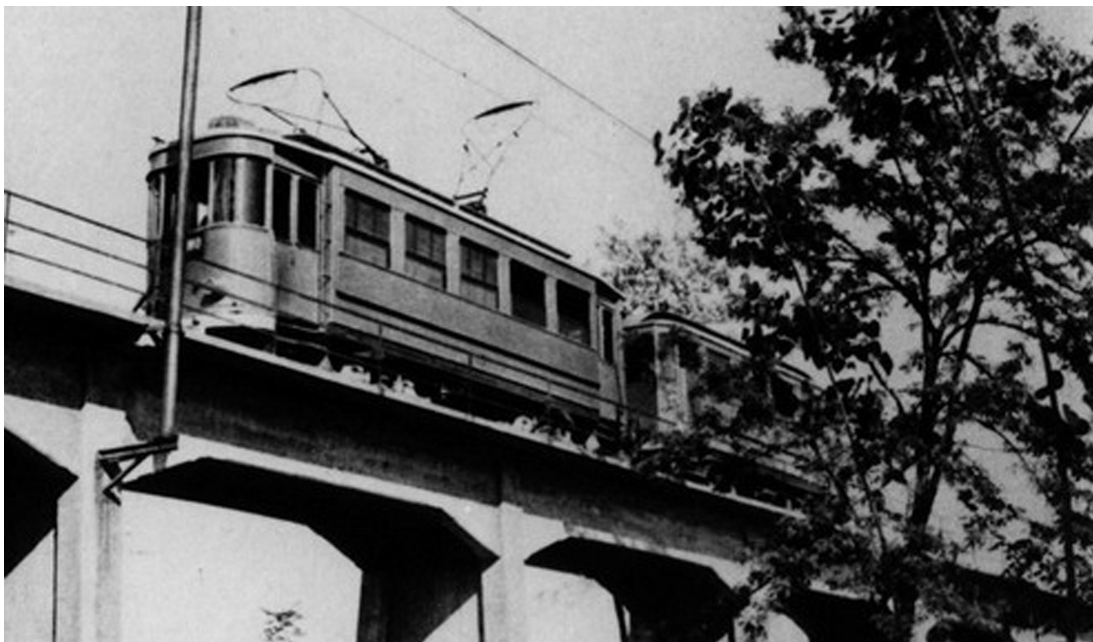
Sul cavalcavia della ferrovia Torino - Chieri
